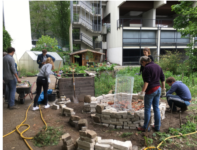
Bau eines Keyhole Garden in den Pallasgärten
