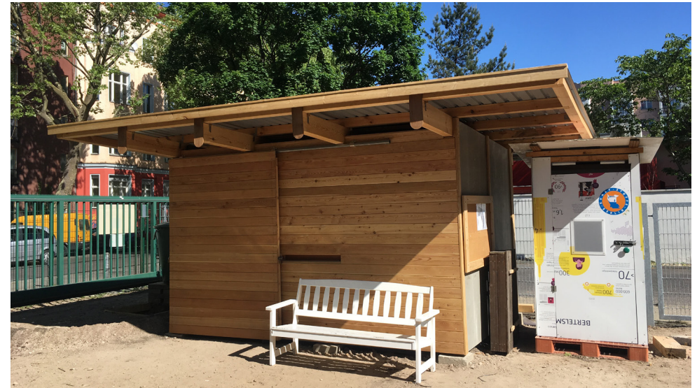
Schuppen und Öko-Toilette
