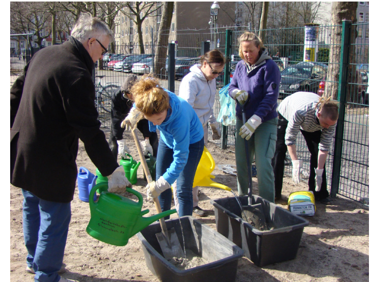
Vorbereiten des Fundaments
