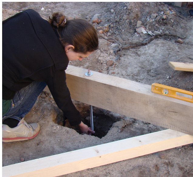
Gießen der Fundamente für den Schuppen
