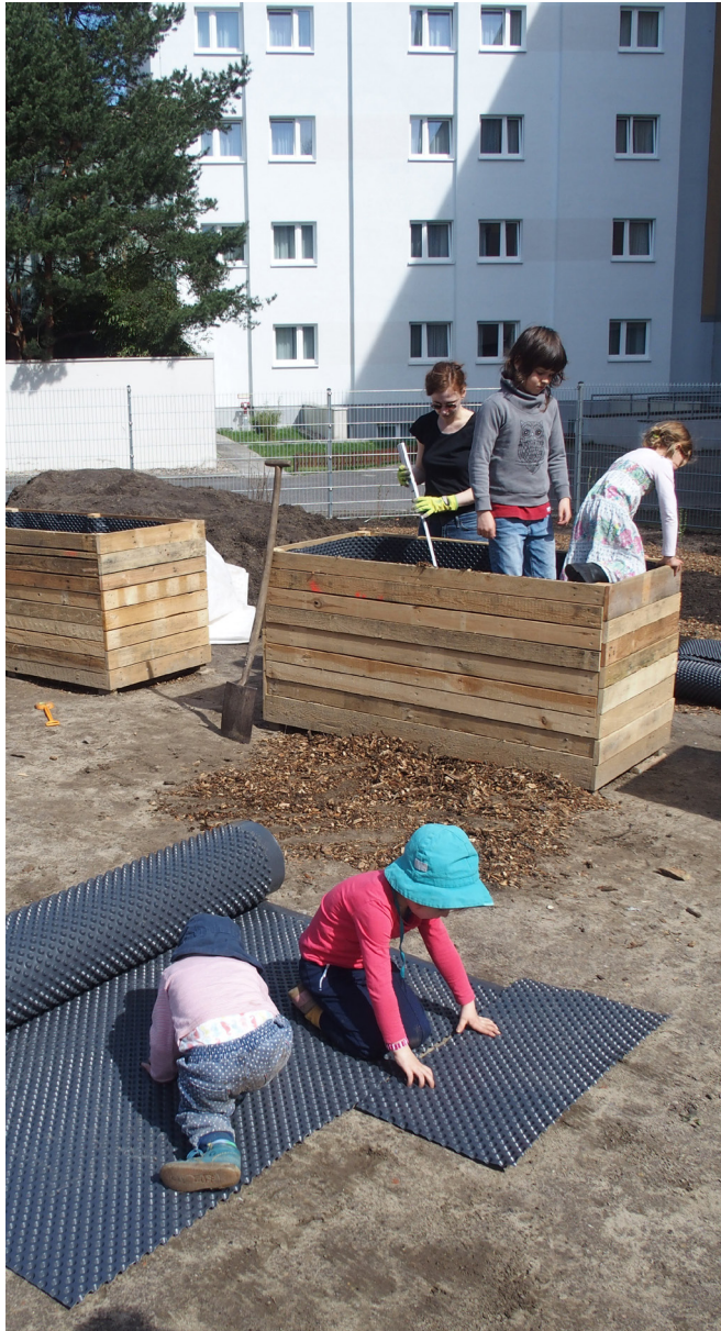
Auskleiden der Hochbeete mit Noppenfolie
