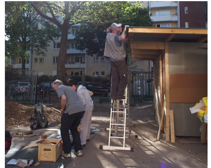
Verschrauben des Dachs
